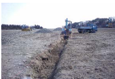
暗渠を埋めているところ
